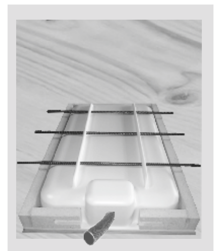
3. Mit Hilfe von Moniereisen das Eingussgehäuse in die Flächenbewehrung einbinden und gegen Auftrieb sichern. Leerrohr zuführen und fixieren.
